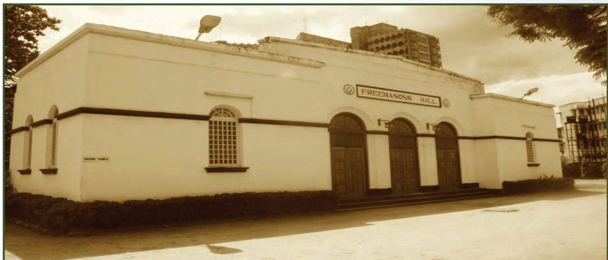
Jengo la Ukumbi wa Freemasons
