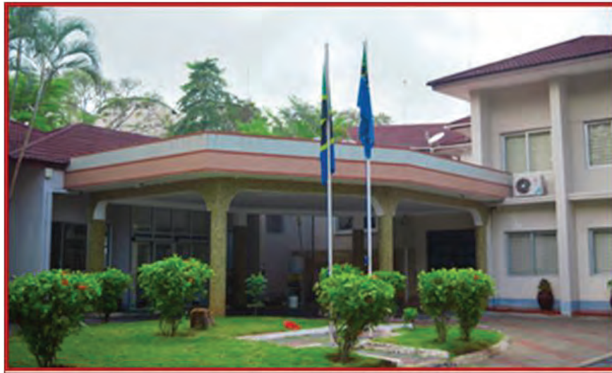
Jengo la Ofisi Ndogo ya Bunge, Dar es Salaam
